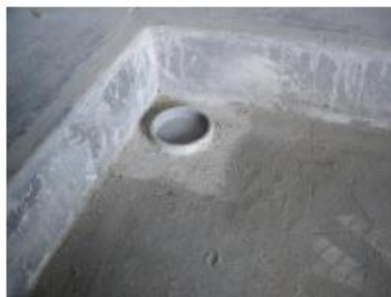
Narożnik po osadzeniu ramy
