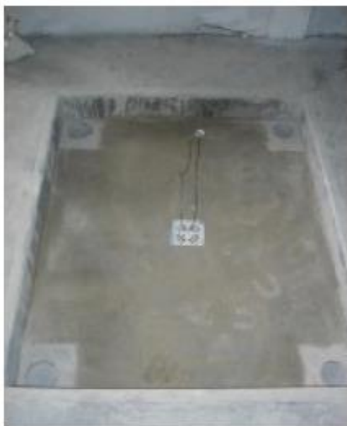
Widok całej ramy po osadzeniu.
